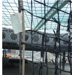
6 Prüfetikette im Eckbereich
