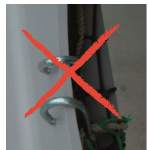
3 Offene Karabinerhaken verlieren massiv an Tragfähigkeit. Grundsätzlich keine Karabinerhaken für die Netzmontage verwenden!
