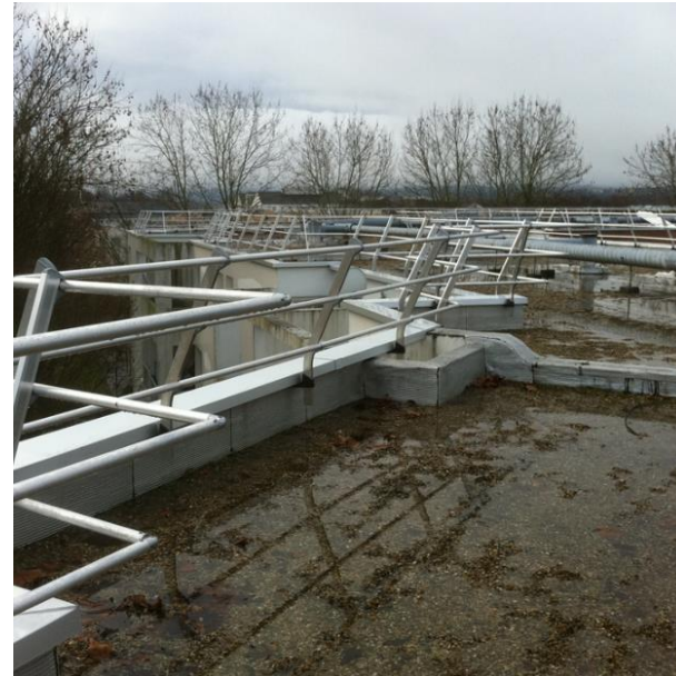
Attika Geländer an Brüstung
